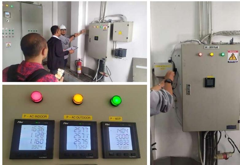
Gambar 3.34 Dokumentasi Instalasi dan Pemasangan Alat Monitoring Konsumsi Listrik
